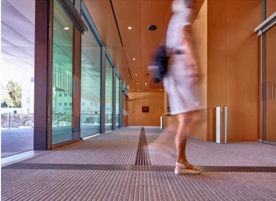
(BU): Bodenidentifikatoren für blinde und sehbehinderte Besucher leicht tastbar: Durch die Kombination von Aluprofilen mit robusten Ripseinlagen und Bürstenprofilen im Farbkontrast und unterschiedlicher Verlegeausrichtung sowie Feldern aus Gummiprofilen ist ein wegführendes Mattensystem entstanden.
